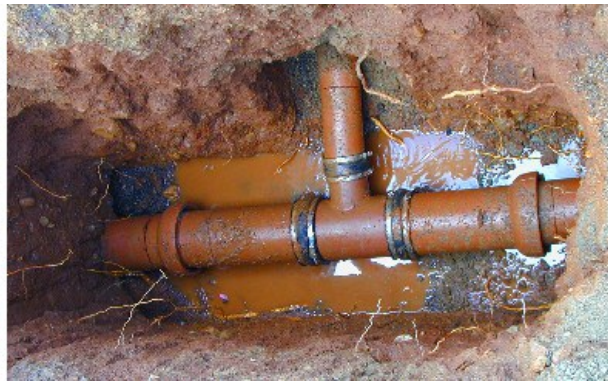
Figure 7. Spot Repair Deerfield Av 2
